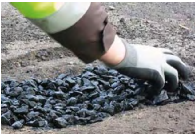
Loch vollständig mit AggreFill™ befüllen
