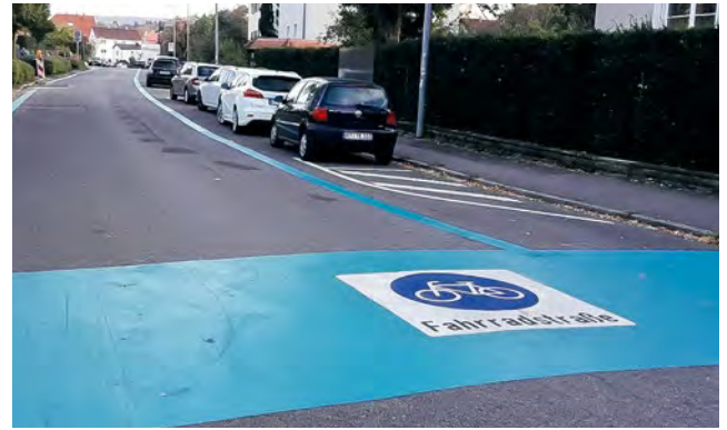
PlastiRoute® RollGrip® für die dauerhafte Markierung mit hoher Griffigkeit auf Schwarzdecken und Beton. Wir empfehlen die Verwendung eines Primers, siehe Infobox unten.
