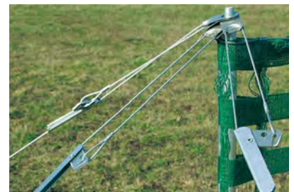
Die Längsabspannung verhindert ein Durchhängen.
