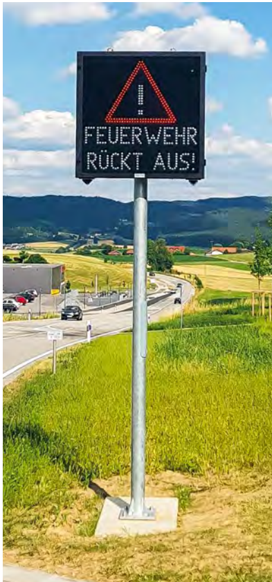
Digitale Wechselverkehrszeichen in LED-Technik stellen eine sinnvolle und effektive Lösung für die Beschilderung einer Feuerwehrausfahrt dar.
