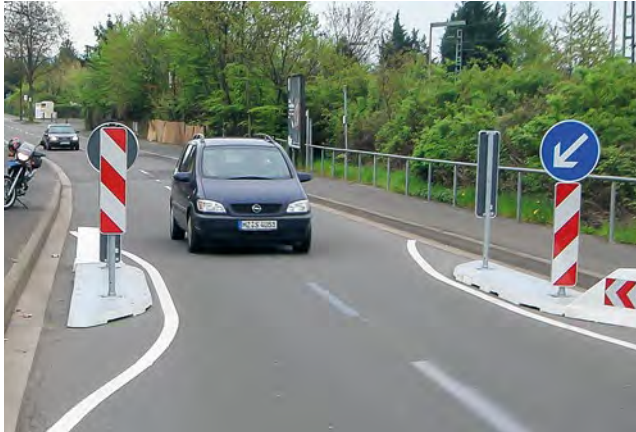
Durch eine Inselbreite von 0,80 m, kann diese mit der Warnkappe (Ralentilor) optisch aufgewertet werden.
