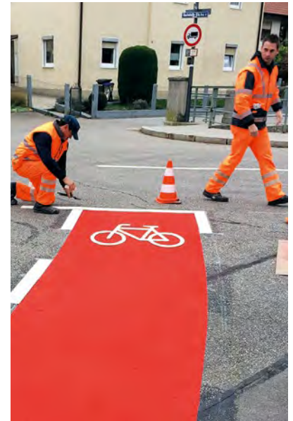
Leicht zu verarbeitendes Material auf Straßen und Bürgersteigen.
