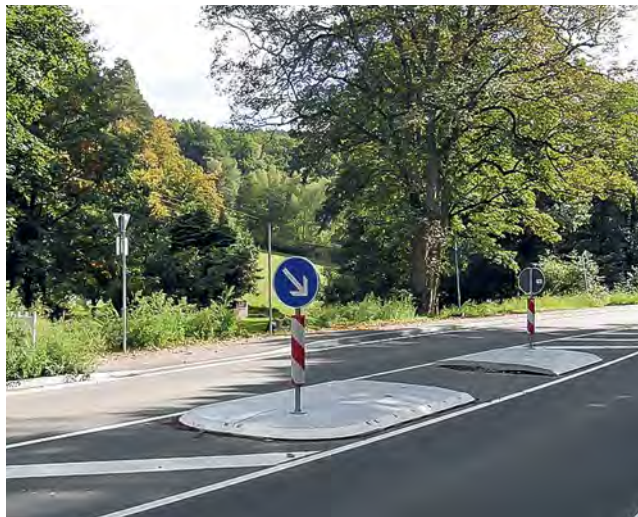
Mit den Reflektoren sind die Verkehrsinseln auch in der Nacht gut sichtbar.
